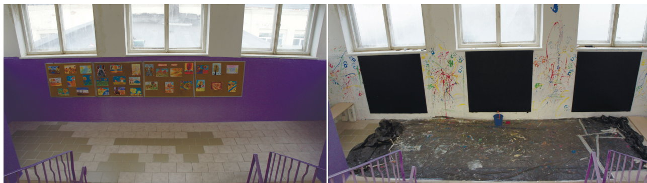
Рисунок 5. Лестничная клетка до и во время ремонта: вместо полноценной меловой стены пришлось установить три фанерных полотна. Фотографии Барсуковой Е.М.
